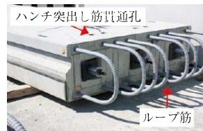
写真-1 頂版スラブ (PRC 構造)
