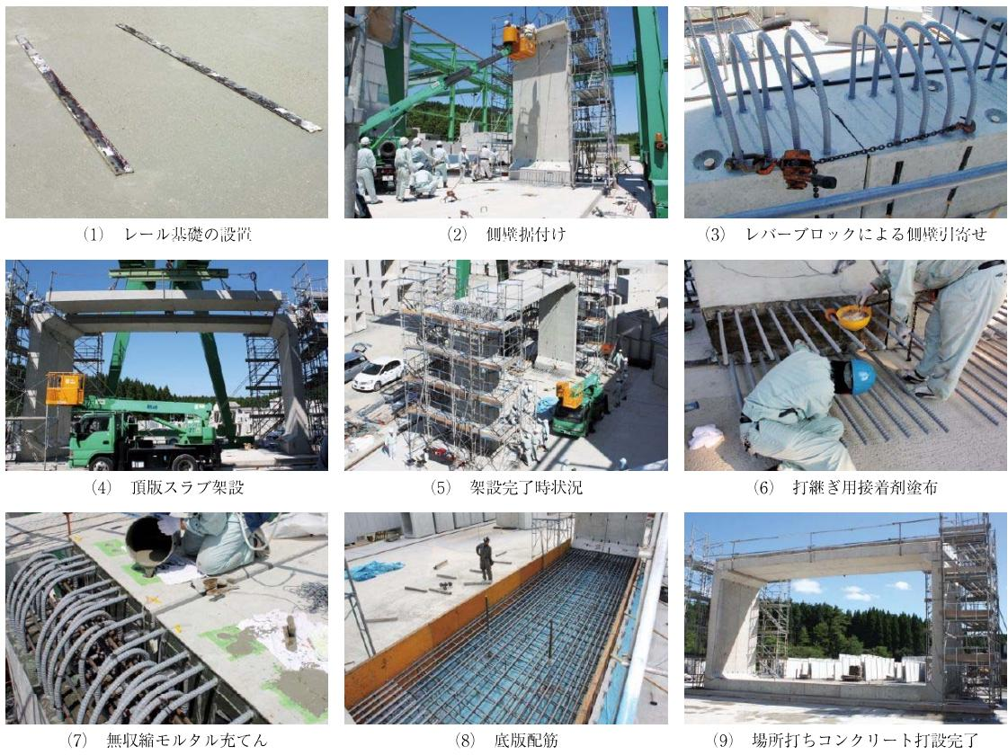
写真-5 組立施工試験状況
