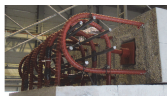
写真－1 隅角部のループ継手組立て状況
