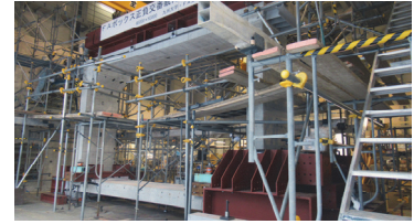
写真-2 実験機材・足場等の組立て完了状況
